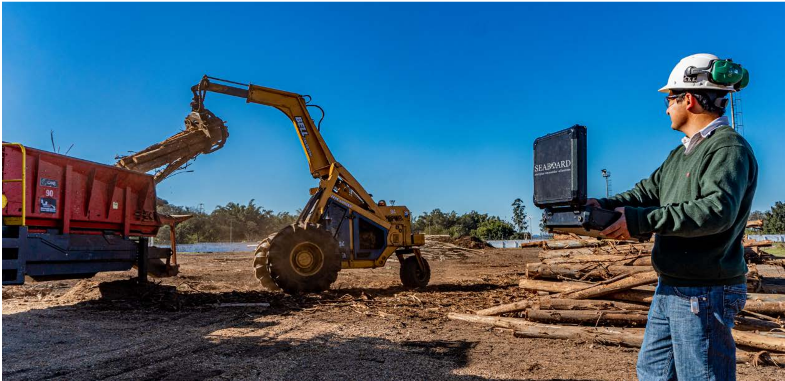
Operación de carga a la mesa de alimentación de la chipeadora.
