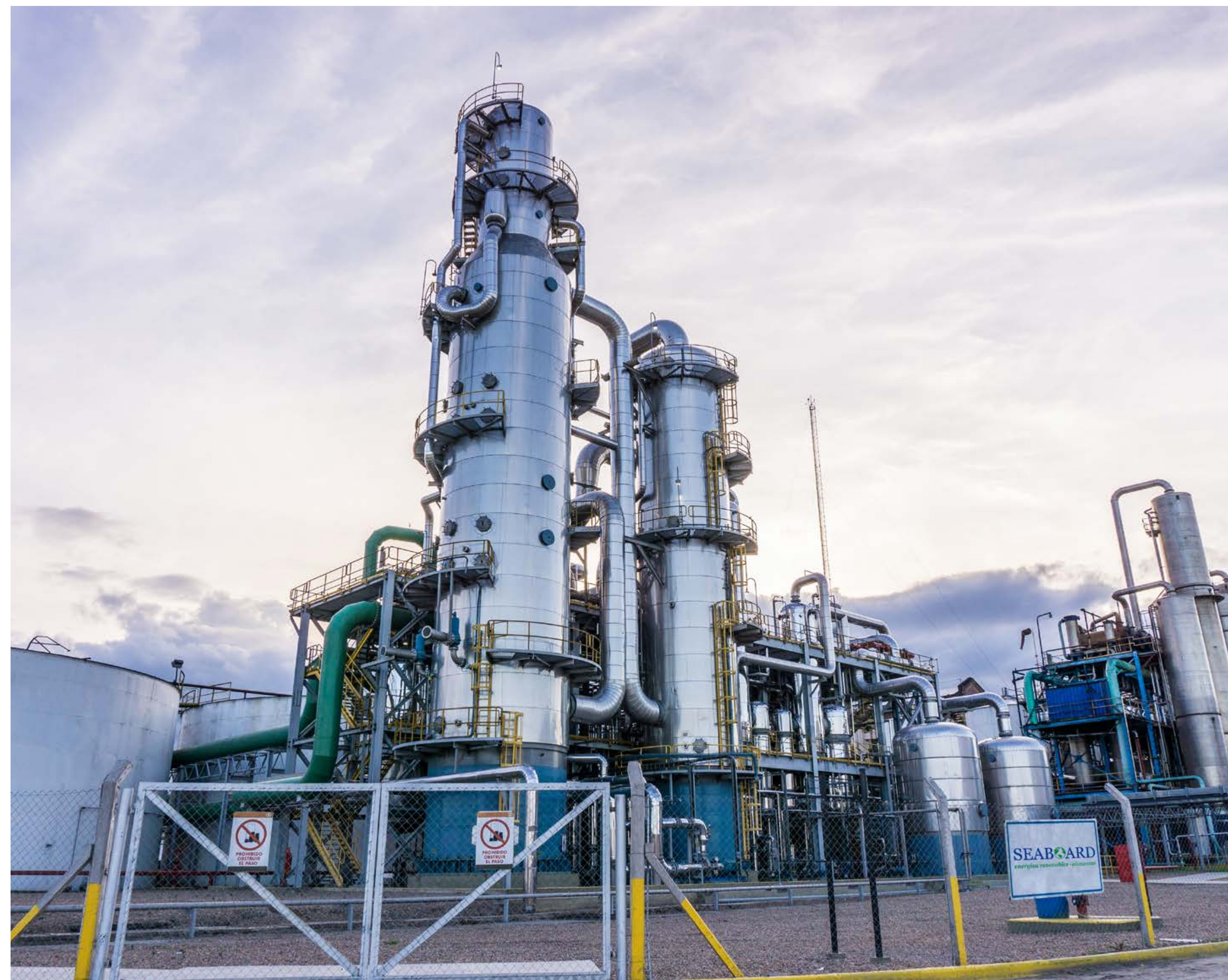
En primer plano la destilería N° 4 (2017) y detrás la N° 3 (2008).
