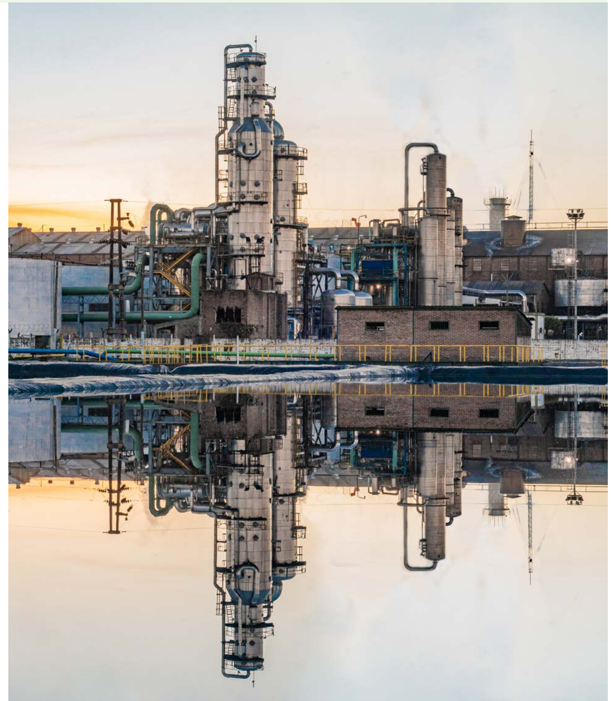
Destilerías N° 4 y N° 3 vistas desde la pileta de recirculación de agua para calderas.
